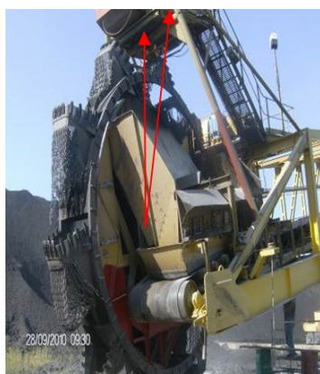
a) Leva strana konstrukcije, savijanje nosača i otkazi ZS
