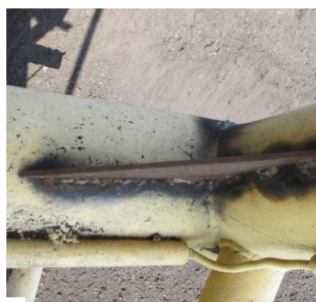
c) Sanirani ZS poprečnog i vertikalnog nosačeg stuba (pogled odozgo)
