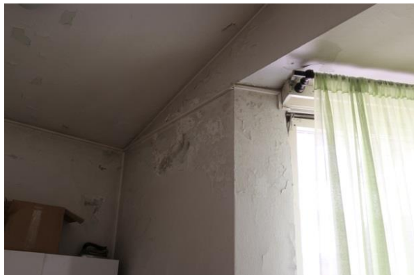
Slika 5 - Stanje unutrašnjih zidova
