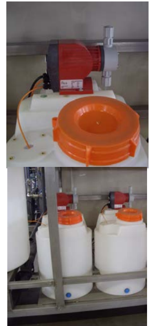
Sl. 4. Rezervoari za antiskalant
