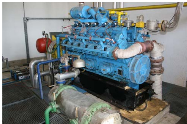
Slika 1. Gasni motor tipa JW 212 G
