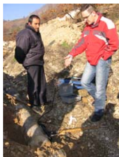
Sl. 4. Postavljanje ultrazvučnog merača protoka vode
