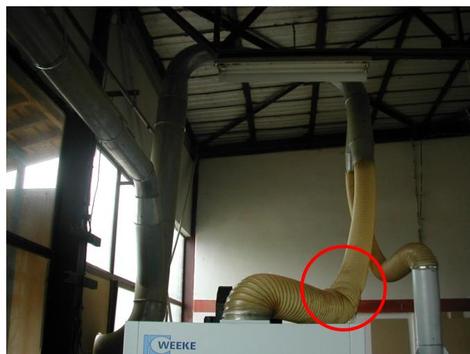
**Slika 3.30** Deformacija cevovoda nastala kao posledica prevelike brzine strujanja
