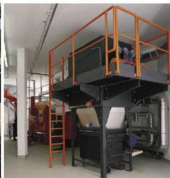
**Slika 4.2 Elektrostatički i keramički filteri**
